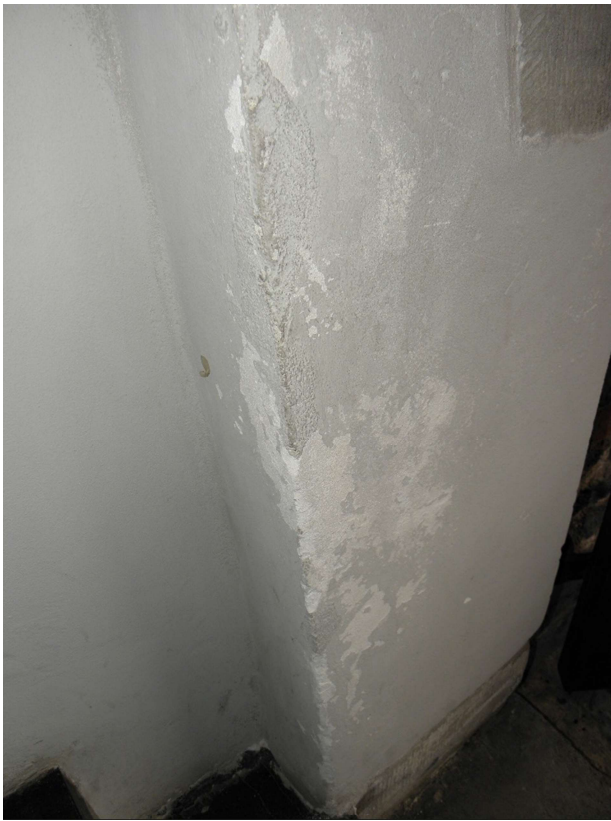
Miejscowe złuszczenia powłok zewnętrznych klatki schodowej Wieży.
